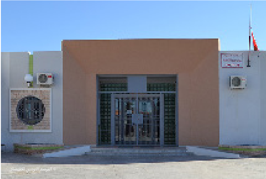
الصورة 3 : مشروع بناء مركز صحة اساسية صنف 4 ببوشمة الذي تابعناه في إطار دراستنا
